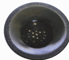
Fig. 14 Brännkopp med hålen täppta av aska. Rengöring är nödvändig.
